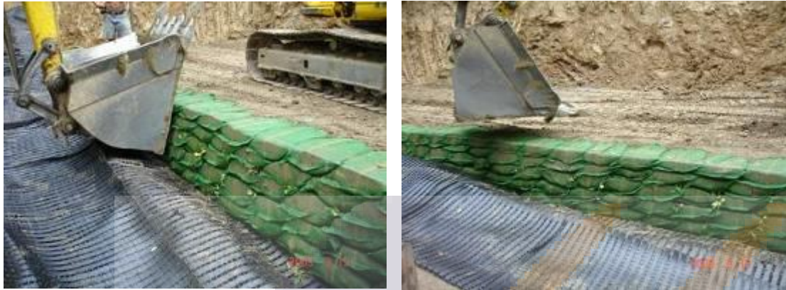
照片 10 土包區之施工概況
