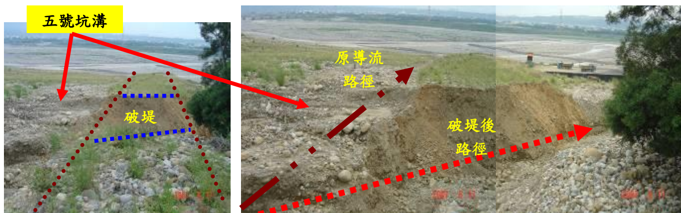
照片 3 火炎山土石流破堤漫流情形
