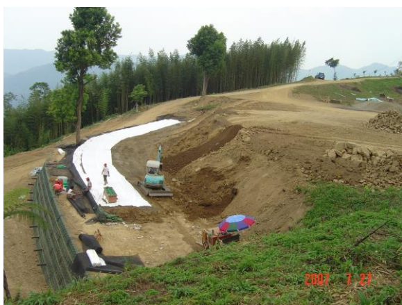
照片 4 施工中之回包式加勁結構
