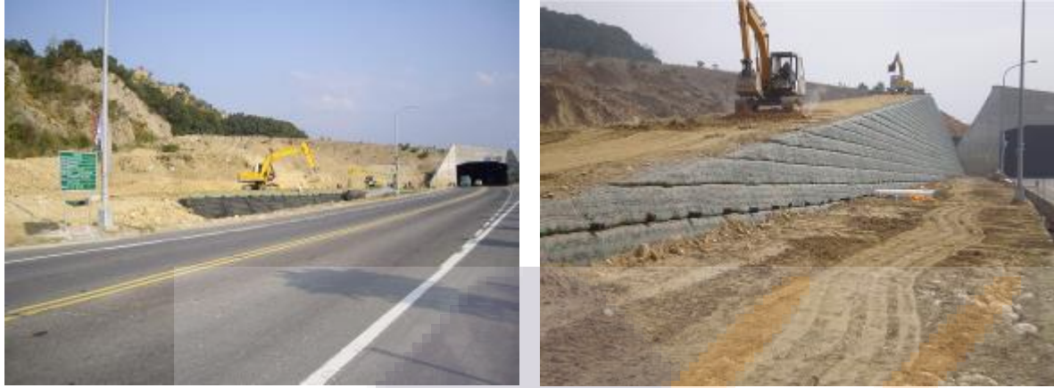
照片 11 施工中之加勁土堤概況
