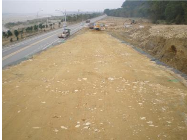
照片 9 加勁土堤之回填料(就地取材篩選之)
