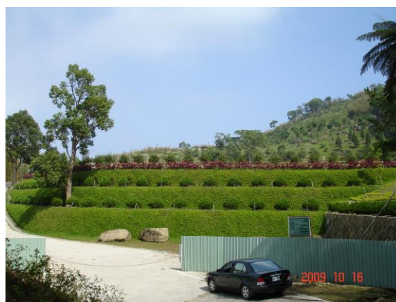
照片 5 植栽後之回包式加勁結構
