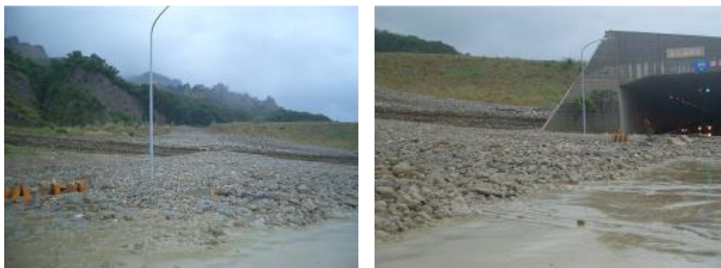
照片 2 火炎山隧道西側出口土石災情
