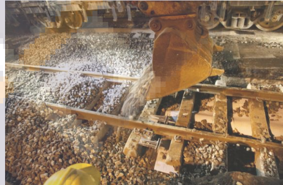
圖 20. 新鮮道碴回填至設計高度
