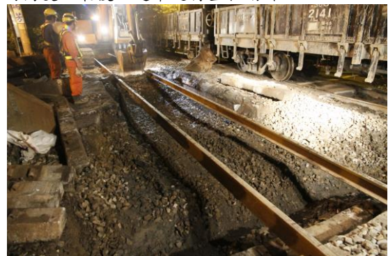
圖 13. 開挖至施工深度
