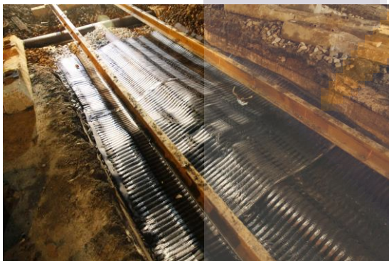
圖 16. 土工格網鋪設
