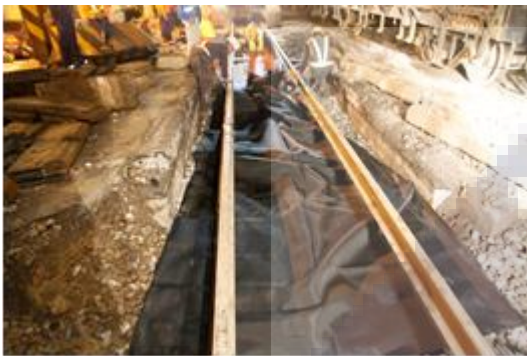
圖 15. 土工織布鋪設
