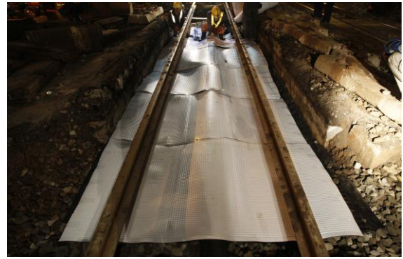
圖 18. 土工排水板鋪設
