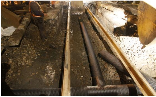
圖 14. 配置排水網管及固定
