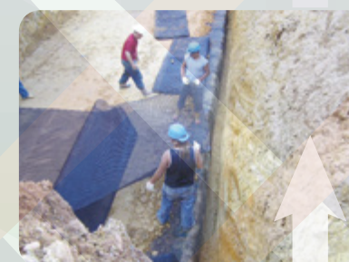
8.第二層格網鋪設 (重複4-7步驟至設計高度)
