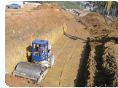
1.基礎整平夯實
