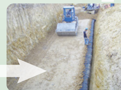
6.第二層回填夯實
