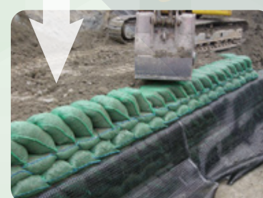
4.第一層回填夯實
