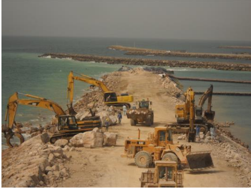
圖 11 外覆拋石施作過程
