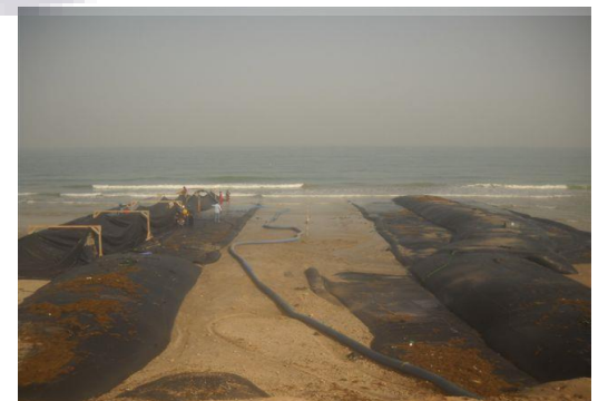
圖 10 土工沙腸袋堤心施作過程
