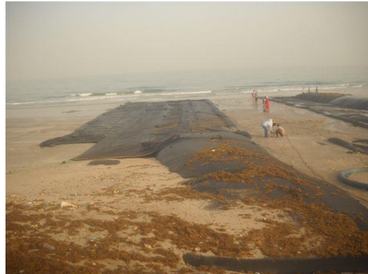
圖 7 土工沙腸袋鋪設過程
