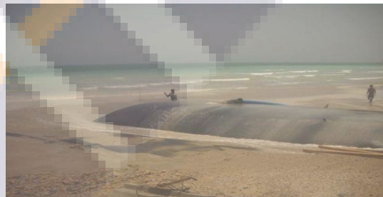
圖 9 土工沙腸袋灌注過程
