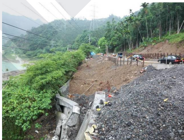
圖2 上邊坡臨時擋土措施
