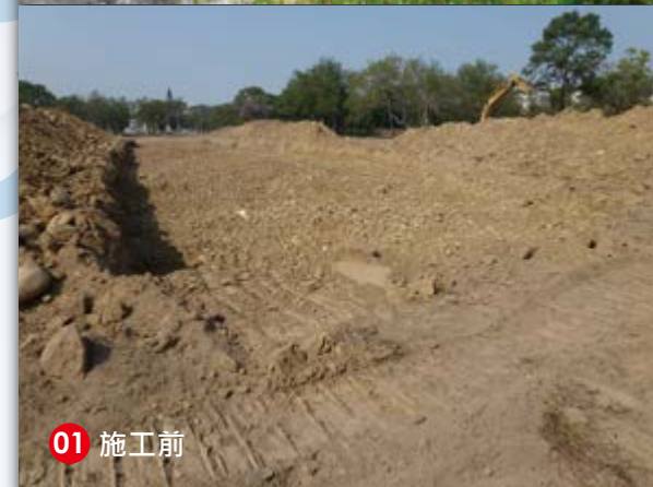
02 施工中 土口袋植生、抗沖蝕網、皂土毯
