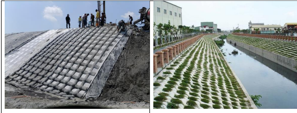
圖 13 織物模板工法
