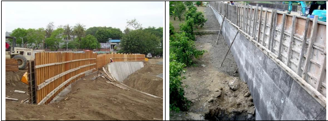
圖 11 傳統 RC 結構使用到的大量模板
